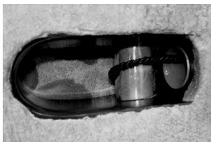
Boîte de guidage moulé dans du béton
