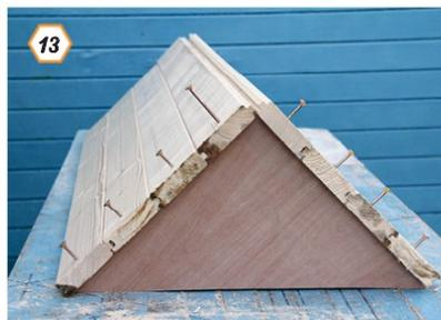
**13** Fixez les lames sur les pignons de toit. 5 lames sont préférables à 4 (comme ici). Elles seront percées au foret à bois de 4 mm avant le vissage. Le profil (1200 x 50 x 50 mm) fera l'étanchéité au faîtage, une fois fixé.
