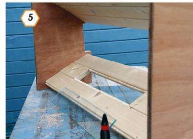
**5** Mettez la vitre en appui sur la languette dans la lame du bas, et sur 2 demi-ronds (de 500 mm), insérez-la dans la rainure de la lame du dessus.
